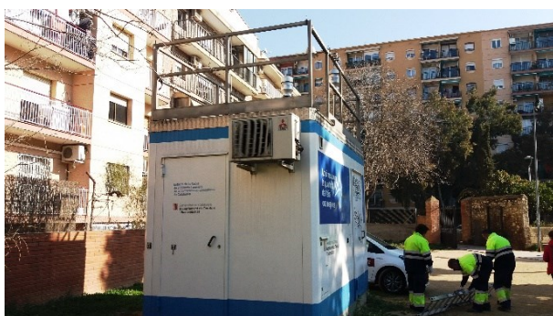
Figura 3. Ejemplo de estación de la XVPCA. Los duplicados y el blanco se sitúan cerca del punto de toma de aire del analizador automático (Santa Coloma de Gramenet).
